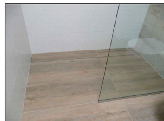
Ducha de obra a nivel de suelo con el mismo pavimento que el resto de vivienda. Mampara de vidrio enrasada.
